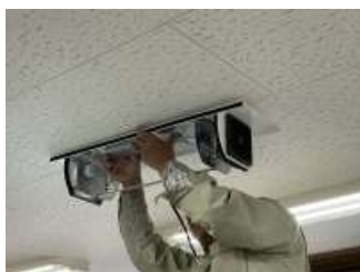
本体取付完了
